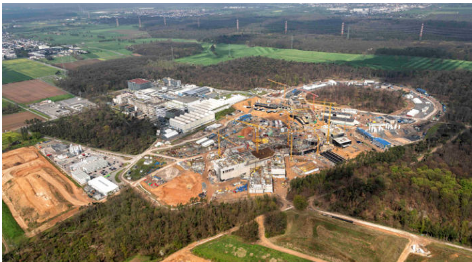
FAIR-Baustelle aus der Luft, April 2023 D. Fehrenz, GSI/FAIR
