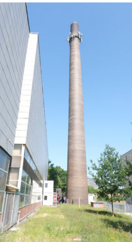
HKW Gießen Außenansicht Bild: Stadtwerke Gießen AG
